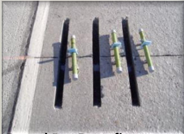
Dowel Bar Retrofit
